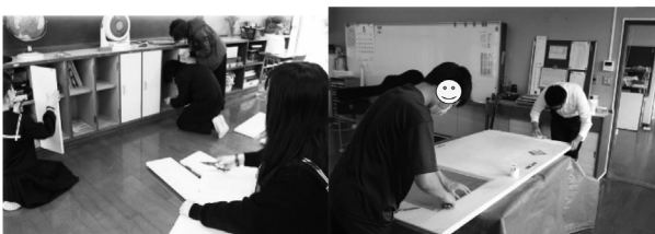
写真7 ロッカーの修理 写真8 ドアの修理とペイント
