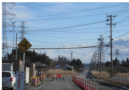
福島県内の状況:福島第一原発の原子炉付近 (2021年12月29日)
