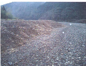
写真2 ツルヨシ群落の繁茂によって複断面化が進行した新荘川の河床(ツルヨシ群落除去後)
