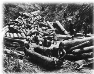
写真2 修羅と木馬出し （大正期の魚梁瀬）
