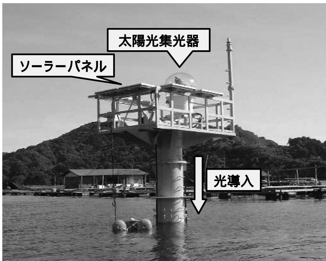
図 10. 高知浦ノ内に設置された太陽光集光装置。タワーの上部に設置された集光器やソーラーパネルから太陽光エネルギーが光ファイバーや発光ダイオード（LED）を通して海底に導入される。
