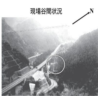
図5a 被害現場（印で囲った部分が被害現場のP5） 右上が北
