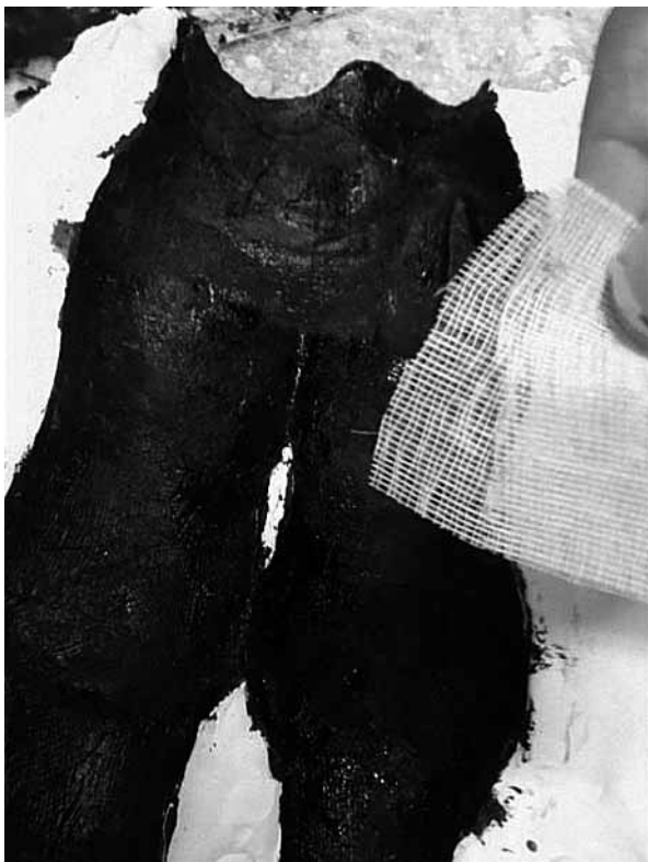
写真10 ガーゼでの補強作業
