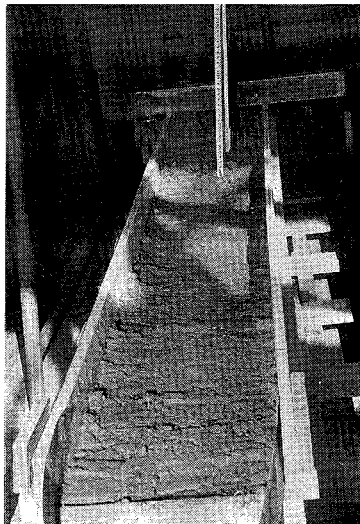
写真3 突き固め中 (上方の四角い棒で)
