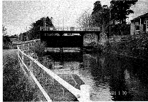
写真2 山田分土工直上流地点
