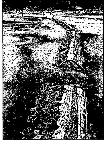
写22 高知市葛島橋上流国分川右岸堤防が溢流で内側より4か所決壊、構造の脆弱性を示す
