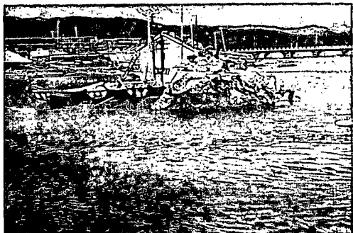
写1 高知市葛島橋西詰国分川堤防の決壊、この1か所の決壊で高知市東部のゼロメートル地帯は12日間滞水した
