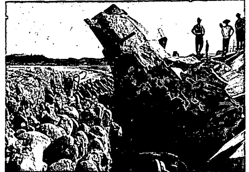
写24 浦戸湾口東部外洋に面する種崎海岸防波堤の決壊、無鉄筋構造の堤防は脆くも倒壊
