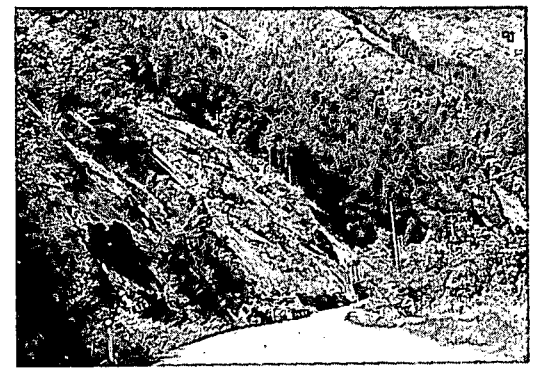
写真4. 点紋帯緑色片岩地帯にみられる層面片理面に沿う流れ盤地じり(Slope sagging型の地じり). 大川村大北川.
