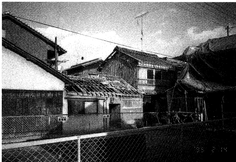
第2写真：瓦は落ちたが潰されずに残った家屋（一宮町郡家地区）
