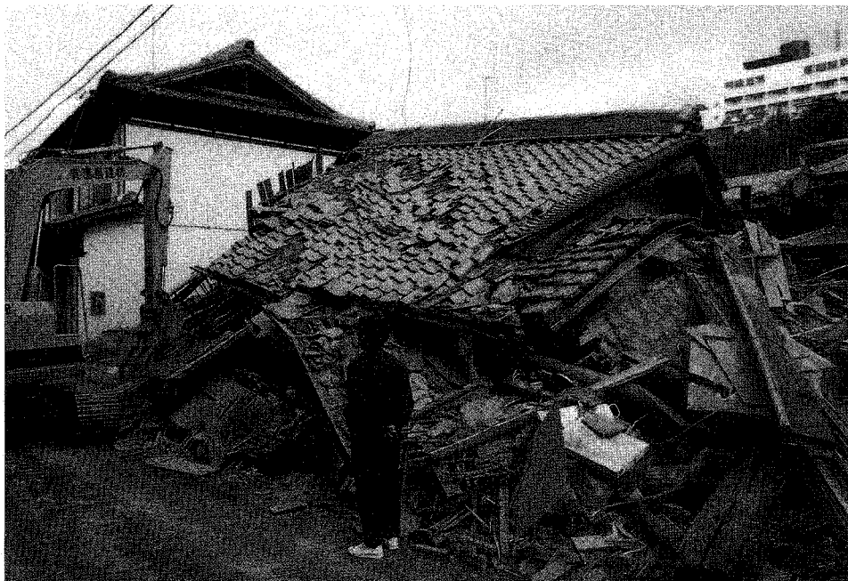
第1写真：屋根に押し潰された格好の家屋（北淡町富島地区）
