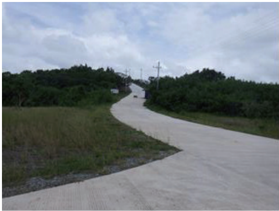
第4写真：台湾の援助で建設中のガラルト州オルとガクラウを 結ぶ集落内のコンクリート道路 (筆者撮影：2015年8月19日)
