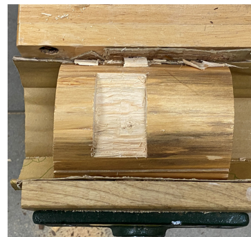
図5. のこぎりで切った溝の深さまでのみで切削した丸太材 (Log wood chiseled to the depth of the groove cut by saw)
