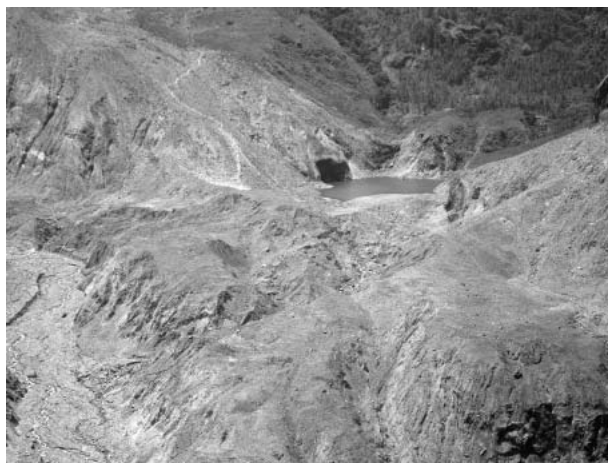
写真-6 天然湖下流の侵食状況
